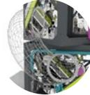
Durchgänge aus dickem rostfreiem Draht schaffen durchbrochene spiralförmige Passagen, die die einzelnen Geräteteile miteinander verbinden. Dadurch wirkt die Struktur leichter und die Kinder können mit einem gewissen Nervenkitzel spielen.
